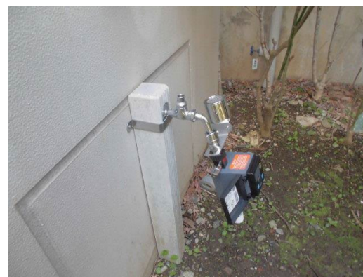
自動散水タイマー付きの灌水装置を蛇口に設置
