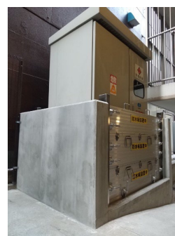
止水板の設置
