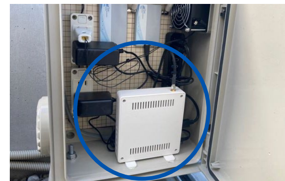
アイミッションズパーク野田 デマンドコントロール(集中制御装置)
